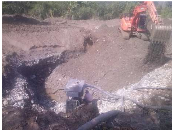
Figura 8-5 Fotografía Referencial de la Excavación de Trincheras de Exploración
