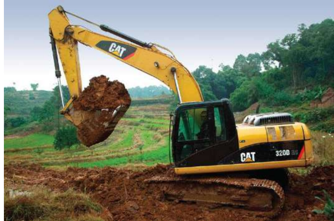
Figura 8-18 Fotografía Referencial de la Remoción de Sobrecarga Fuente: Cristian Yanouch, 2018
