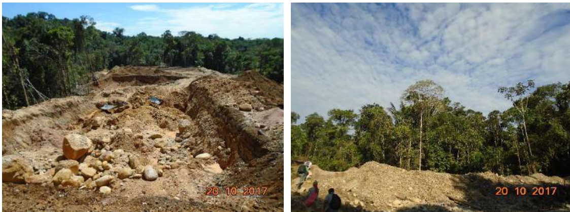
Figura 12-5 Excavación y acumulación de material
