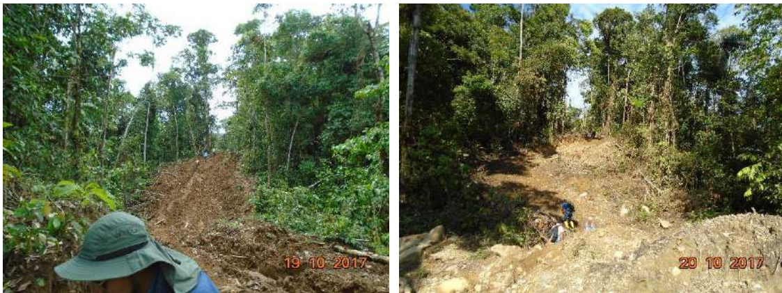
Figura 12-2 Caminos abiertos con maquinaria pesada
