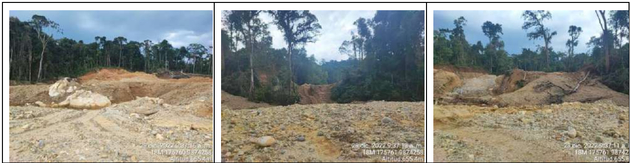
Desbroce y retiro de cobertura vegetal para extracción de material
