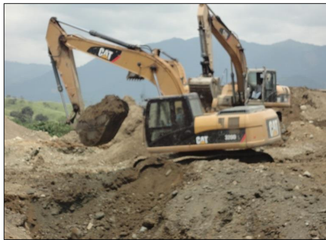
Ilustración 14. Fotografía remoción de sobrecarga.
