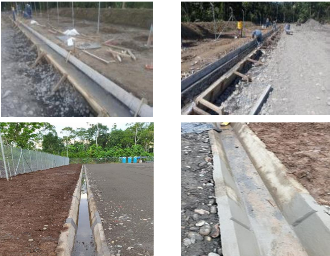
Figura 8 Cunetas Perimetrales TIPO
