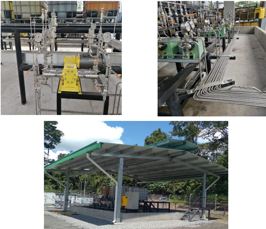
Figura 34 Sistema de Inyección de Químicos TIPO
