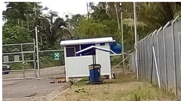
Figura 39 Área Almacenamiento de Desechos TIPO
