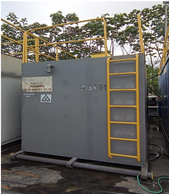
Figura 41 Planta de Tratamiento de Aguas (PTAR) TIPO
