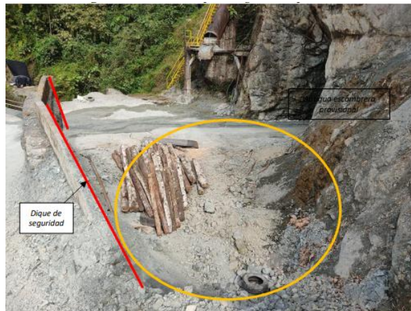
Figura 178. Vista lateral, dique de seguridad al pie de escombrera. Fuente: Departamento técnico “Quebrada Fría”
