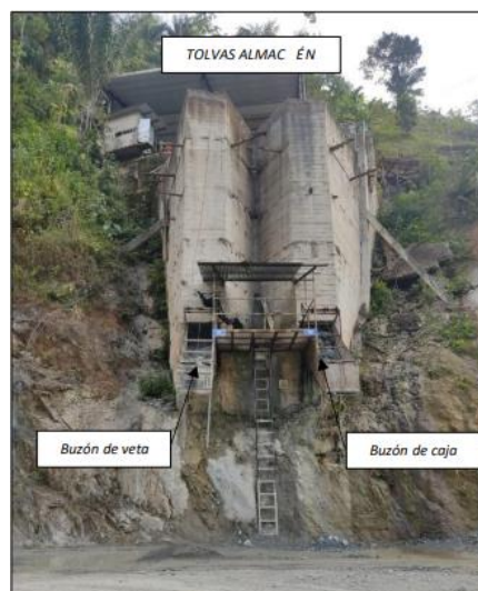
Figura 172. Tolvas para el almacenamiento de material de caja y veta (actual escombrera) Fuente: Departamento técnico “Quebrada Fría”
