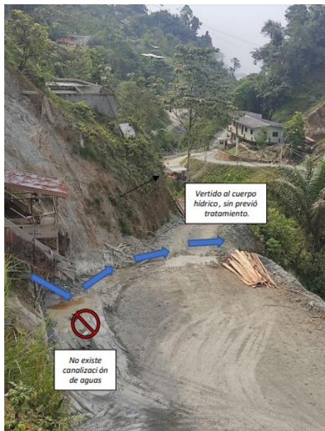
Figura 176. Drenaje de aguas provenientes de las tolvas almacén. Fuente: Departamento técnico “Quebrada Fría”
