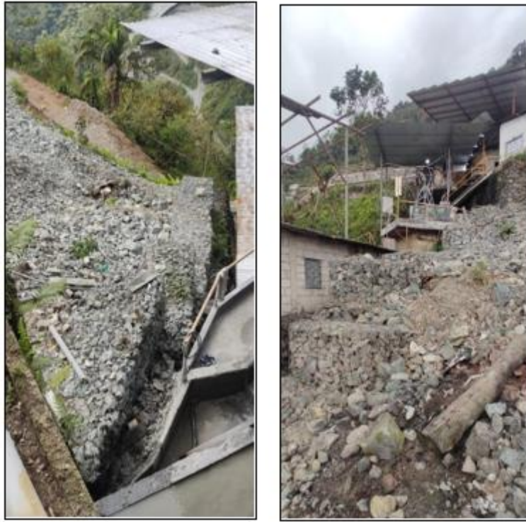
Figura 169. Muros de sostenimiento laterales, protección a infraestructura contigua. FUENTE: Departamento técnico “Quebrada Fría”, 2023.
