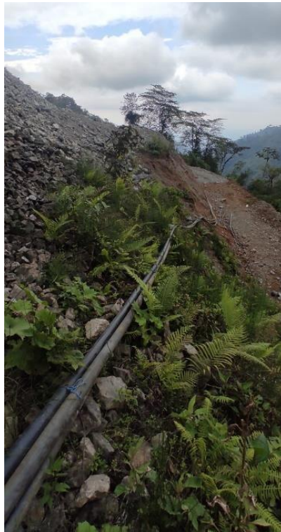
Figura 171. Canalización de aguas a pie de talud. FUENTE: Departamento técnico “Quebrada Fría”, 2023.
