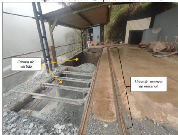
Figura 173. Corona de tolva, depósito de material de mina Fuente: Departamento técnico "Quebrada Fría"
