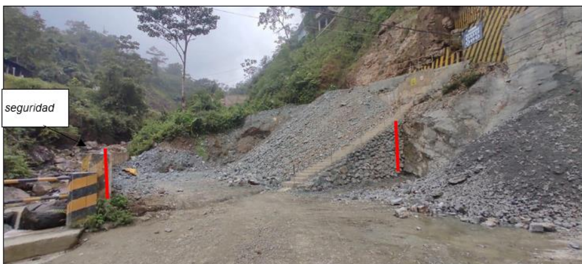
Figura 162. Vista lateral, dique de seguridad al pie de escombrera. Fuente: Departamento técnico “Quebrada Fría”
