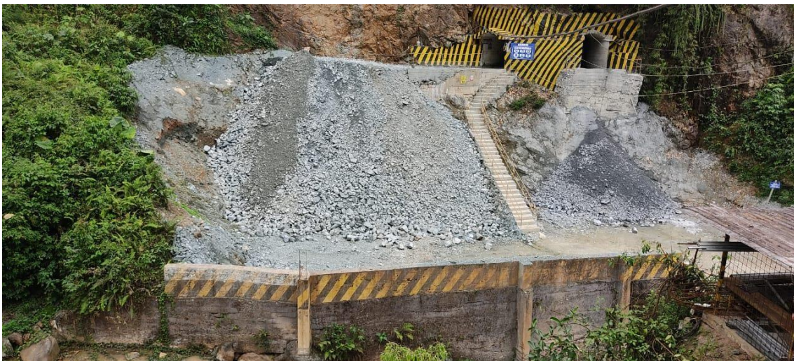
Figura 161. Estado actual de la escombrera “Grupo 96” Fuente: Departamento técnico “Quebrada Fría”
