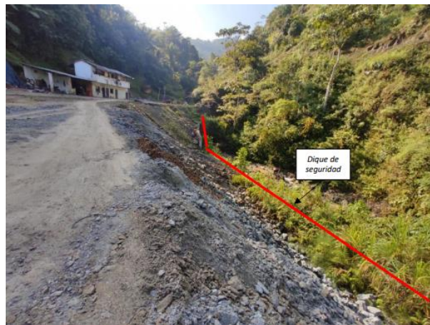
Figura 183. Vista lateral, dique de seguridad al pie de escombrera. Fuente: Departamento técnico “Quebrada Fría”
