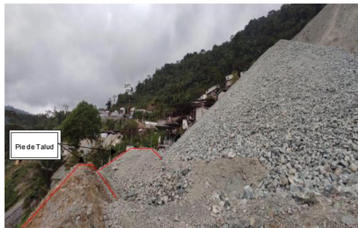
Figura 168. Vista lateral izquierda del dique de seguridad al pie de la escombrera “JGP” FUENTE: Departamento técnico “Quebrada Fría”, 2023.
