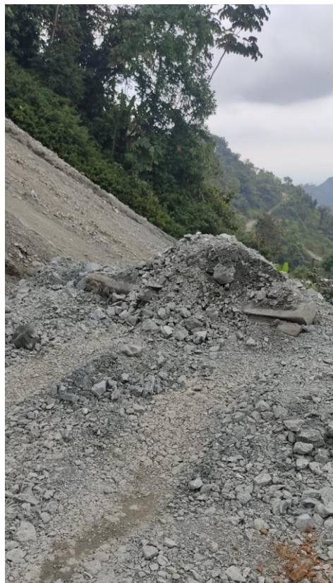
Figura 170. Corona de talud, punto de vertido de estériles. FUENTE: Departamento técnico “Quebrada Fría”, 2023.
