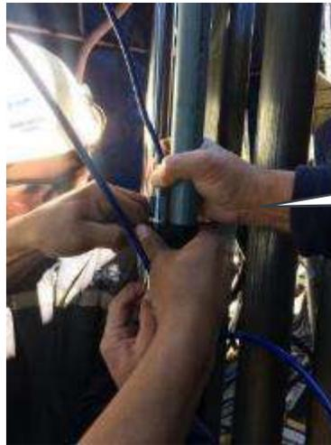
Instalación de los transductores
