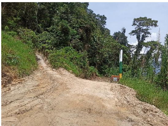
Fotografía 6.5-26 Finde la vía Remolino II
