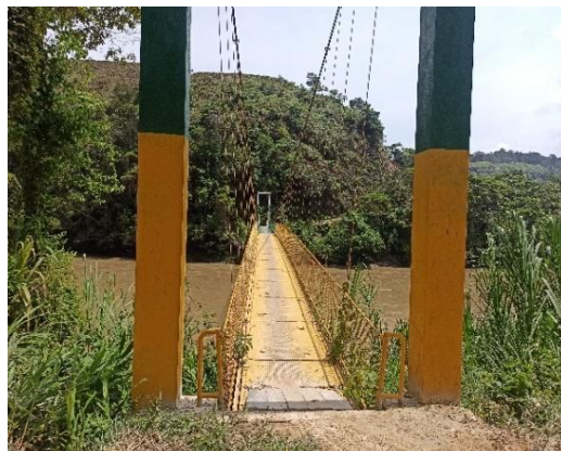
Fotografía 6.5-27 Puente peatonal río Zamora
