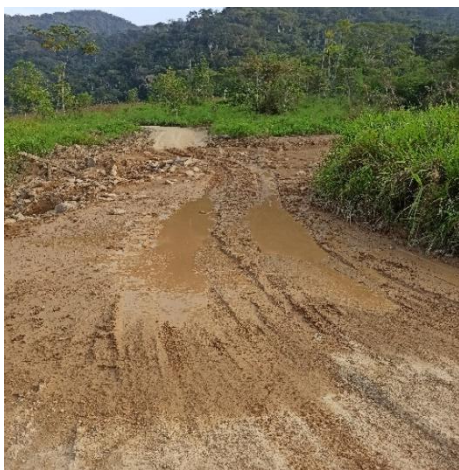
Fotografía 6.5-24 Camino al puente Florida
