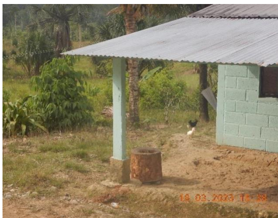
Fotografía 6.5-16 Viviendas en Remolino II
