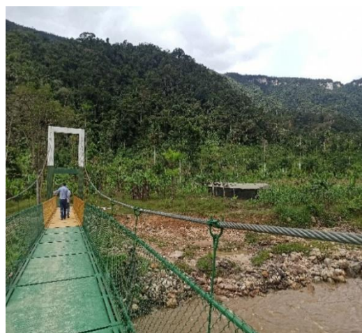
Fotografía 6.5-25 Puente peatonal Florida
