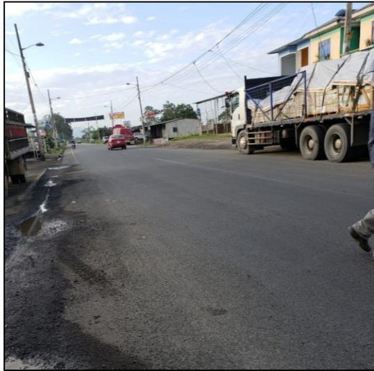
(a) Acceso a la Concesión Minera El Fénix, Vía Camilo Ponce Enríquez
