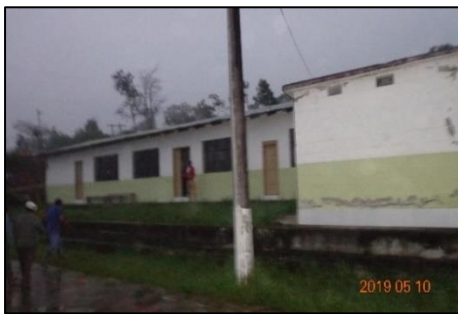
Foto 027 Casa Comunal Fecha: 10/05/2019 Fuente: Gesambconsult
