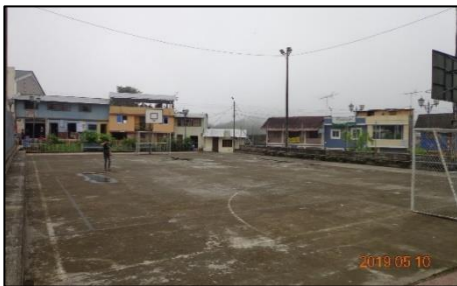
Foto 009 Cancha Multiple Fecha: 10/05/2019 Fuente: Gesambconsult
