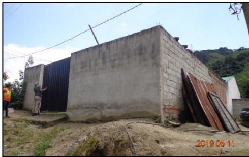
Foto 041 Casa comunal Fecha: 11/05/2019 Fuente: Gesambconsult
