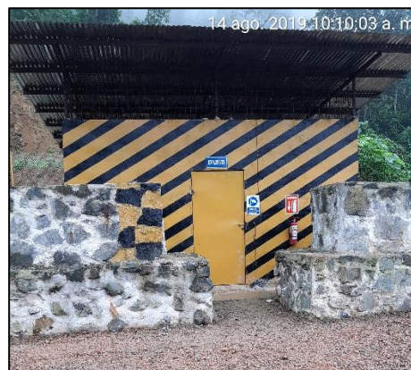
Fotografía 6.2.7 Almacenamiento de Explosivos
