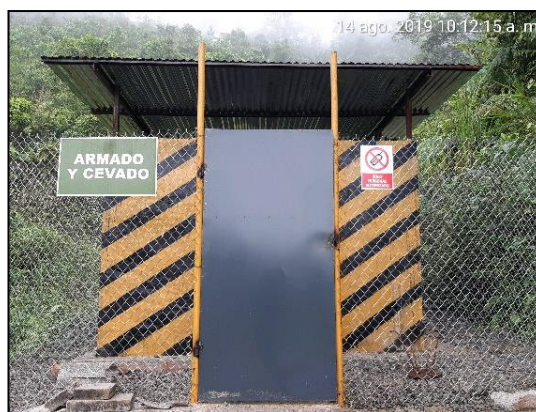
Fotografía 6.2.8 Armado y Cebado
