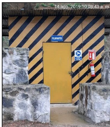
Fotografía 6.2.6 Almacenamiento de Fulminantes
