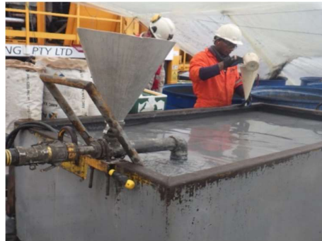
Figura 8-34 Manejo de Lodos de Perforación
