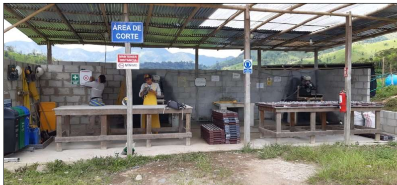
Figura 8-25 Cuarto de Corte de Testigos.
