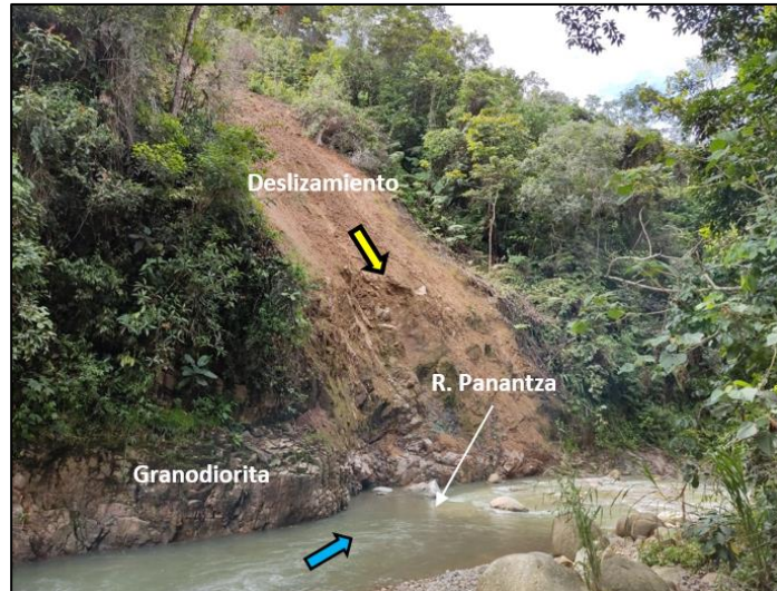
Fotografía 9-2 Deslizamiento Traslacional en el Río Panantza. Localizado en las coordenadas 783.267,72E y 9.650.345,29N, 899 msnm
