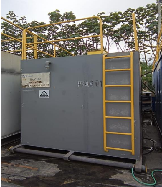
Figura 31 Planta de Tratamiento de Aguas (PTAR) TIPO
