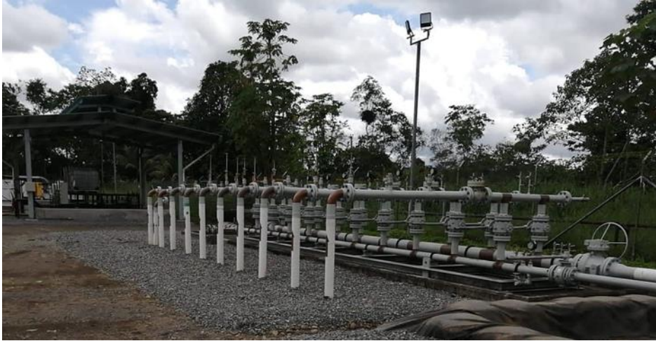
Figura 33 Múltiple de Producción TIPO
