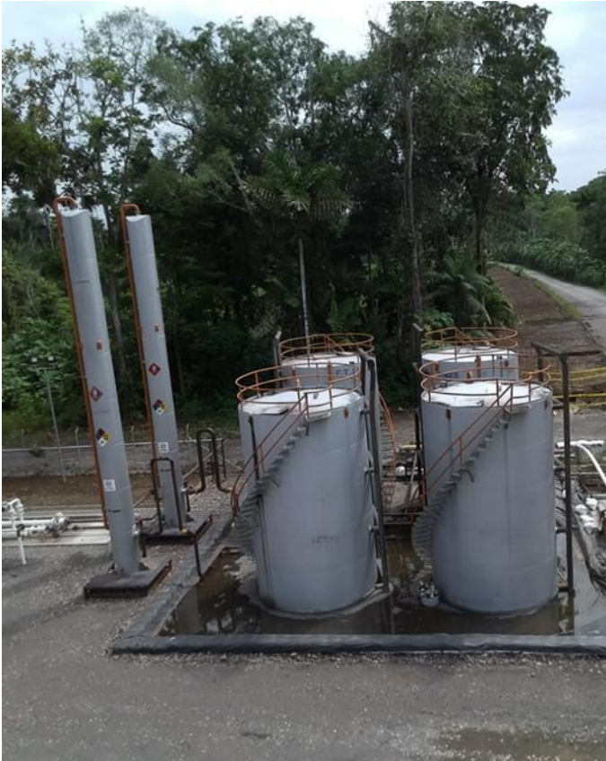
Figura 34 Sistema de Separación TIPO
