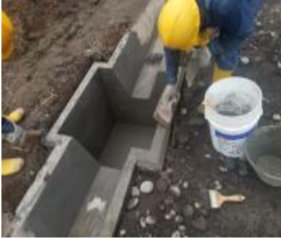
Figura 11 Desarenadores TIPO
