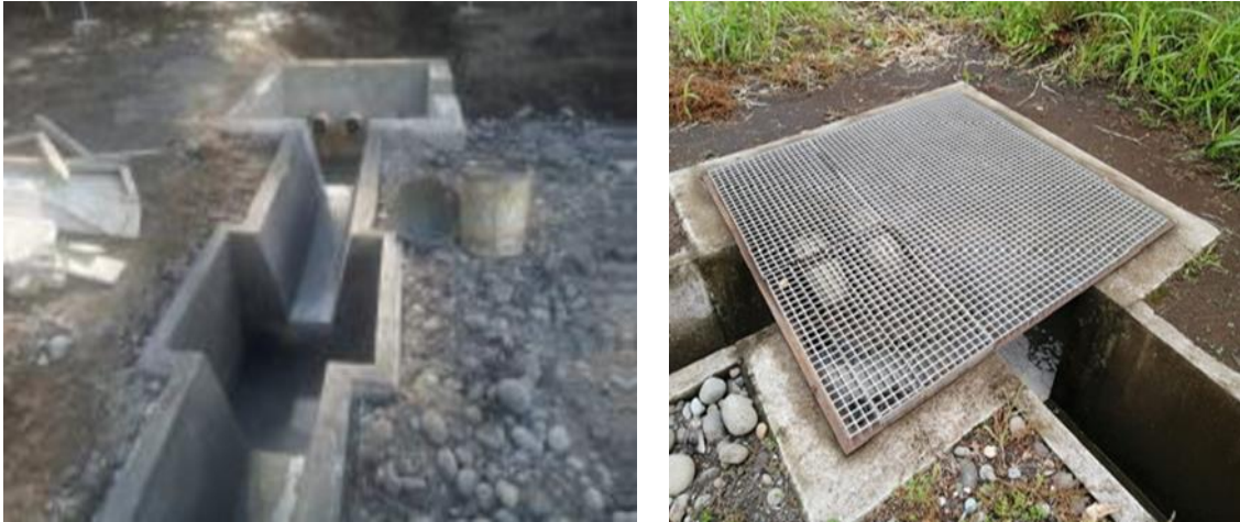
Figura 9 Trampas API TIPO
