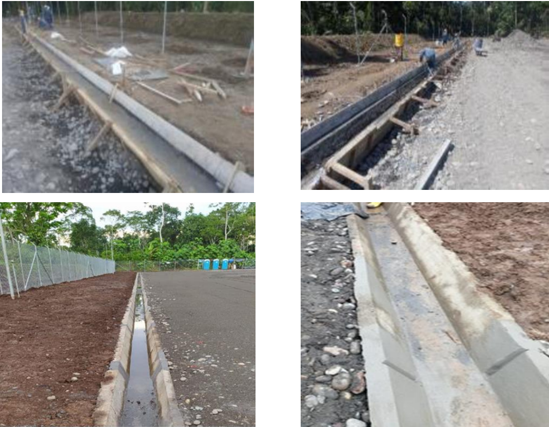
Figura 8 Cunetas Perimetrales TIPO
