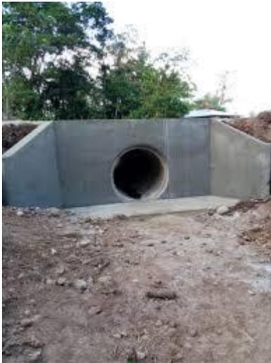
**Figura 3-28 Cabezal de alcantarilla de hormigón armado**
