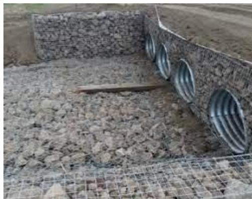
**Figura 3-27 Cabezal de alcantarilla de muro de gaviones**
