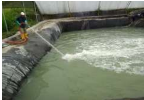
Figura 8-42 Recirculación por Medio de Bomba
