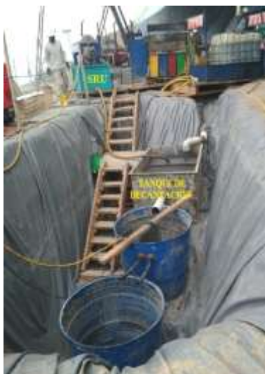
Figura 8-10 Sistema de Sedimentación de Lodos
