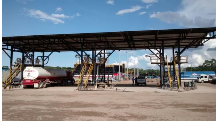
Figura 5-22 Cargadero de crudo y/o agua de producción
