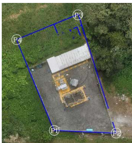
Ilustración 4. Área de la Subestación 5
