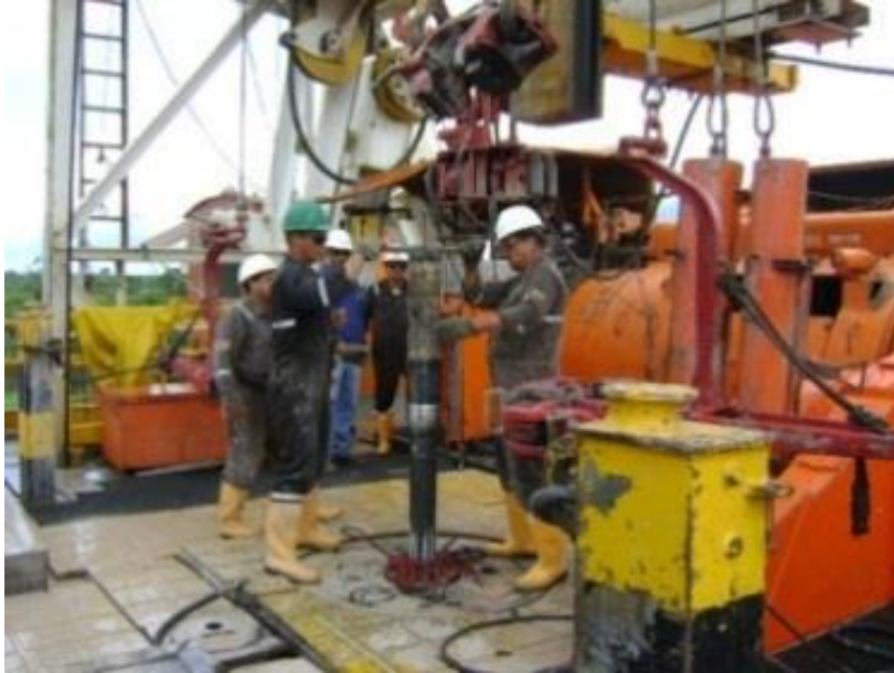
Foto 14. Sistema de levantamiento
