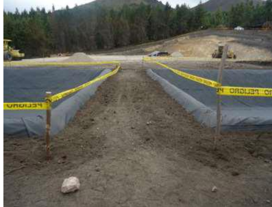
Foto 16. Ejemplo de piscinas de rios de perforación
