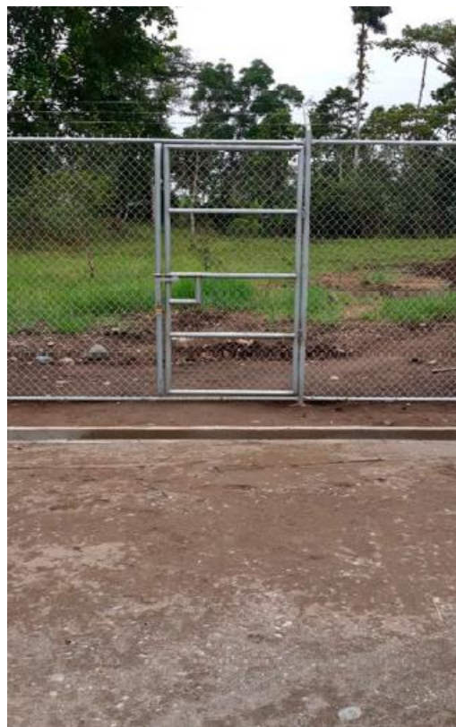
Foto 12.Ejemplo de Cerramiento perimetral
