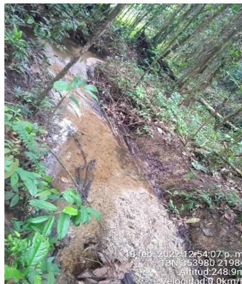
Foto 17. Evidencia de cuerpos de agua alrededor del área de construcción del tramo de acceso
