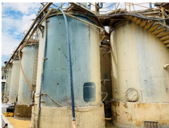
Ilustración 7.13. Tanques para el circuito de carbón activado
