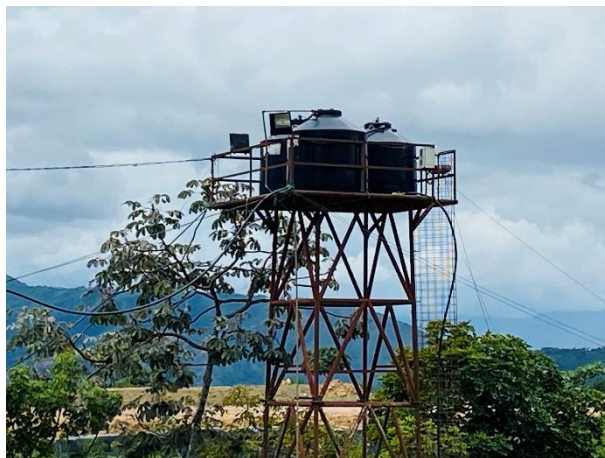
Ilustración 7.41. Tanques de almacenamiento de agua
