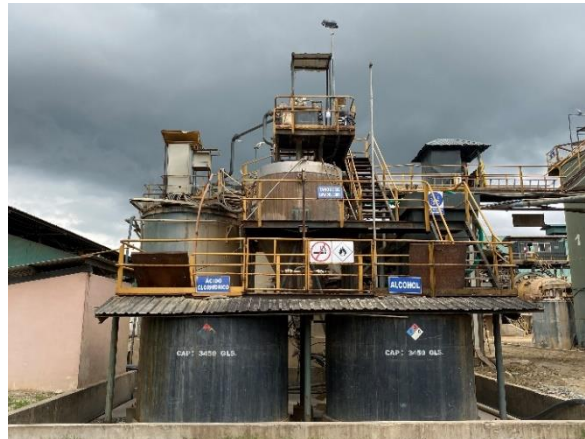
Ilustración 7.14. Lavado ácido del carbón activado
