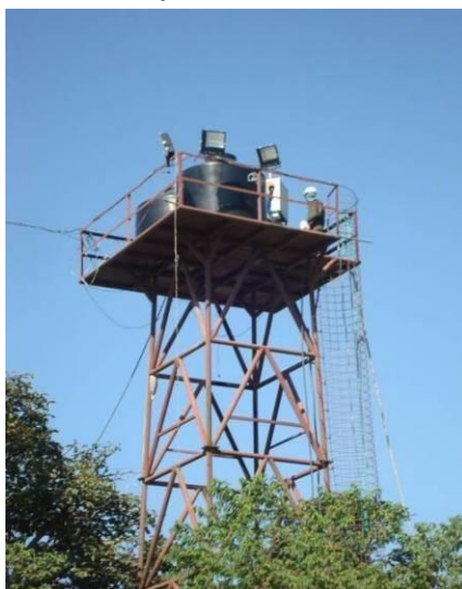
Ilustración 7.46. Tanques de almacenamiento de agua
