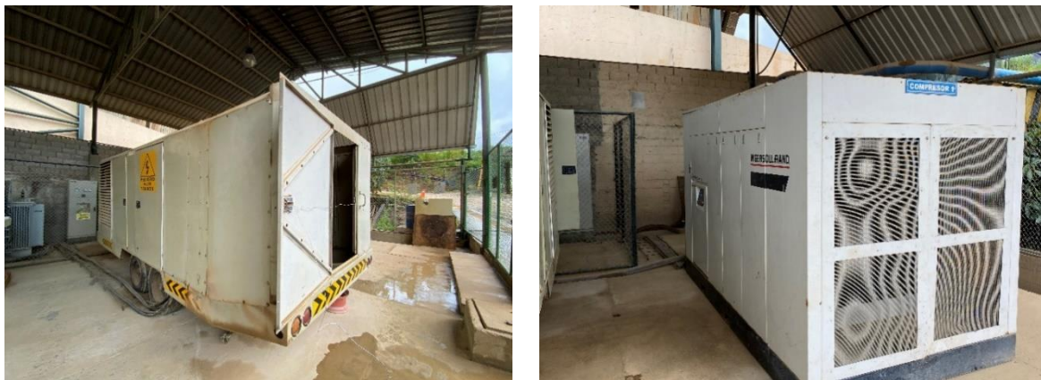
Ilustración 7.37. Compresores eléctricos para área de lixiviados
