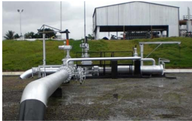
Figura 3-49 Trampas lanzadora y receptora
