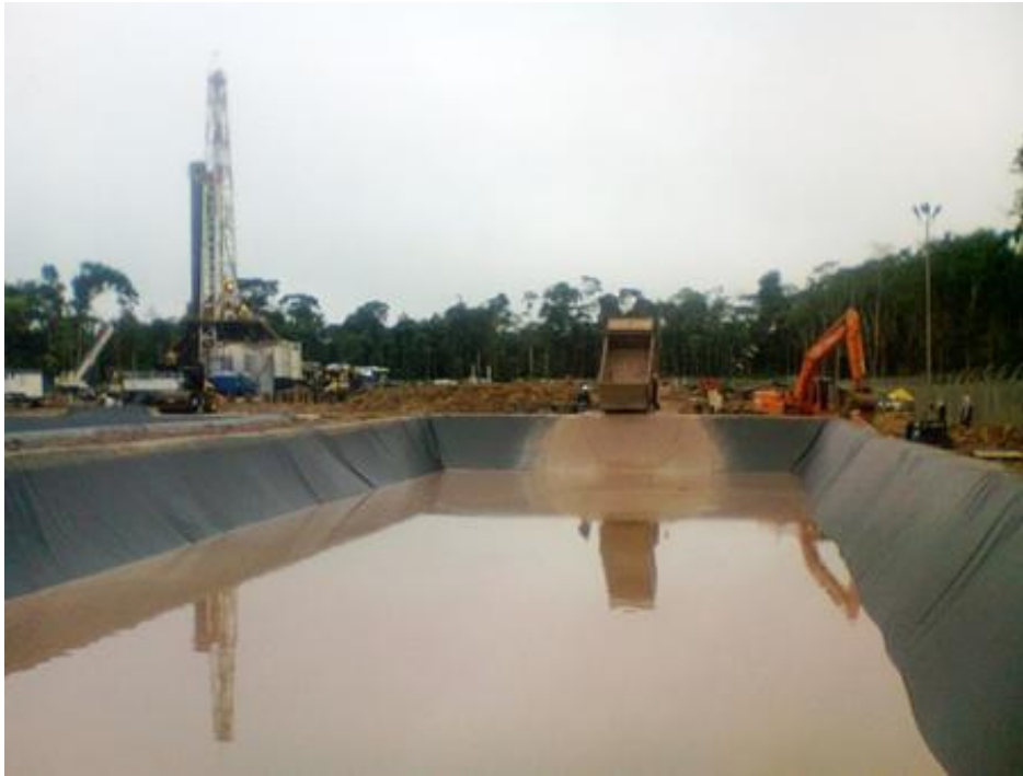
Figura 3-20 Ejemplo de piscina de ripios de perforación excavada
