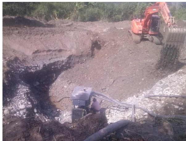
Figura 8-6 Fotografía Referencial de la Excavación de Trincheras de Exploración
