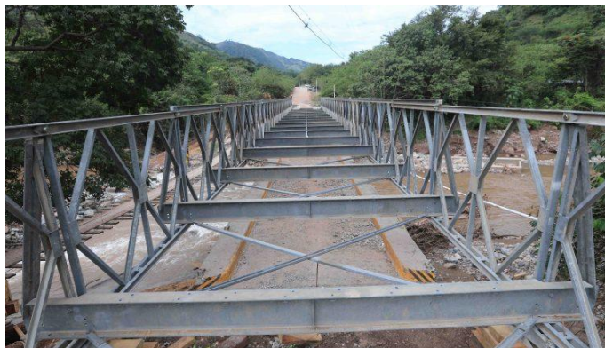
Figura 8-31 Ejemplo de puente tipo Bailey
