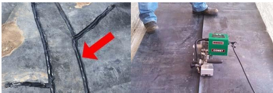
Imagen 7.5. Termofusión de la geomembrana.
