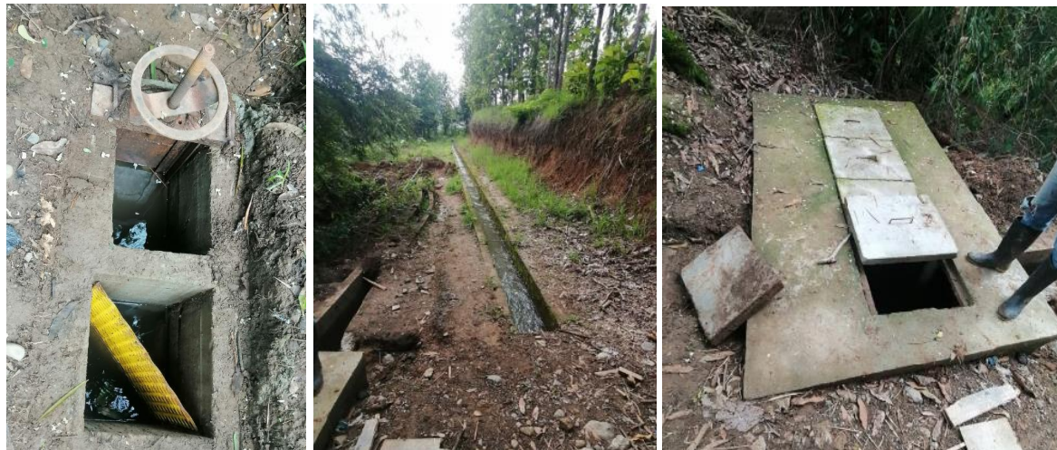
Imagen 7.8. Obras de captación
