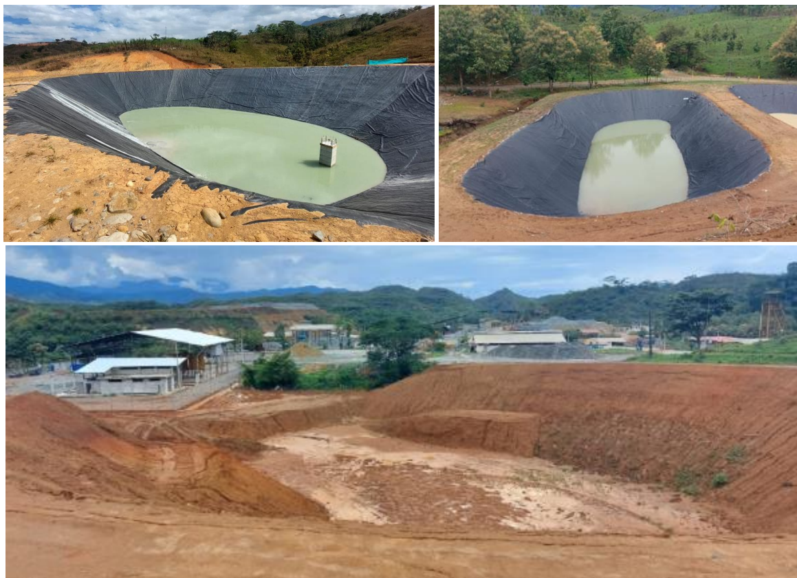
Imagen 7.14. Relaveras 1 y 3 construidas, la Relavera 2 en proceso de construcción
