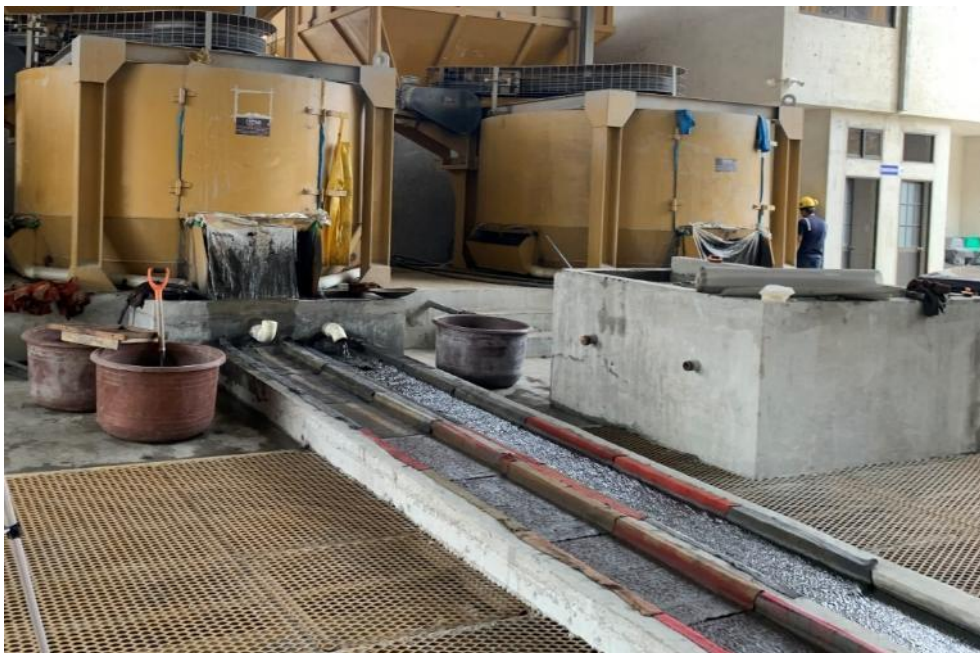
Figura 4-4 Canalón y estanque de cemento
