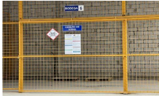
Bodega cianuro de sodio
