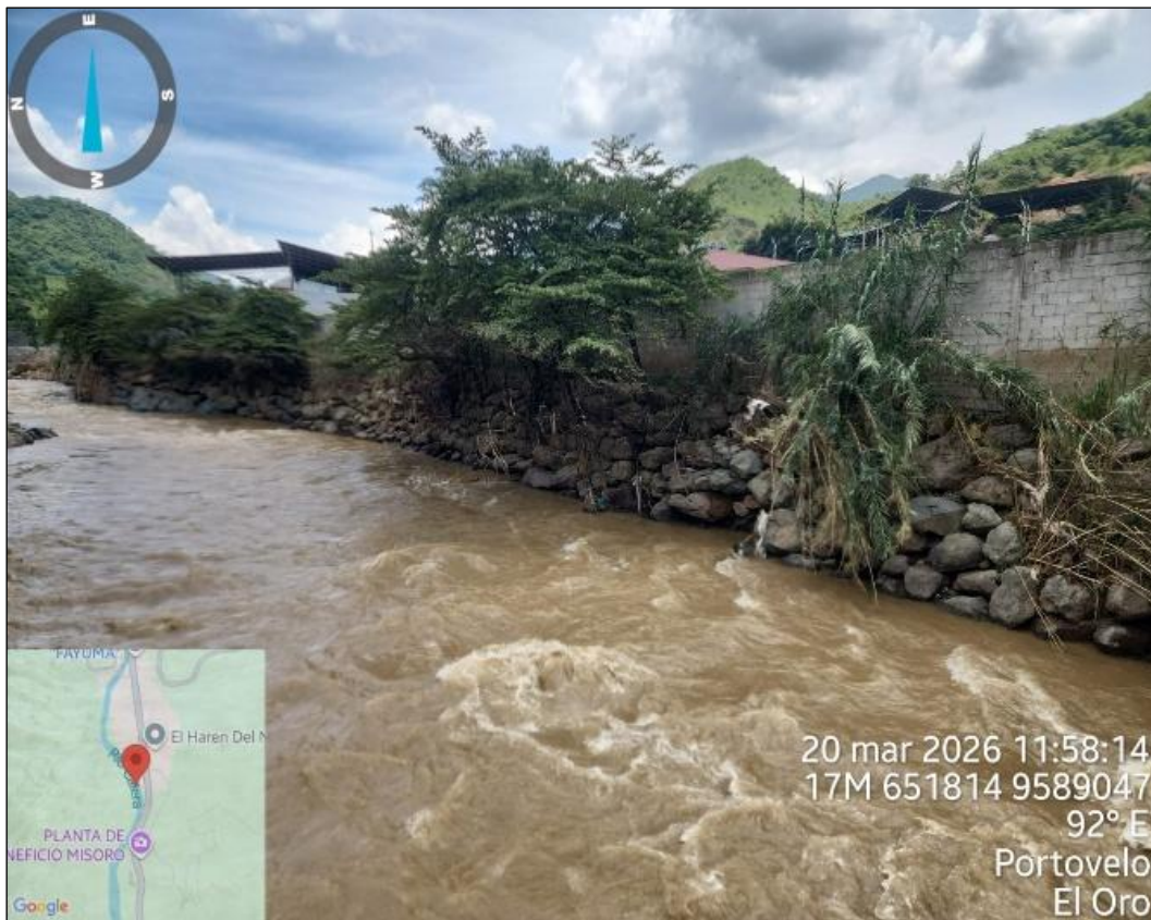
Figura 3-21 Evidencias llanura de inundación Planta Cayo Gold
