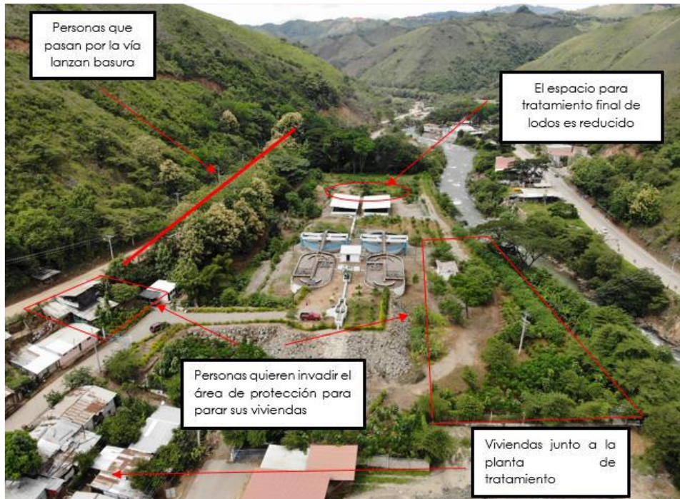
Figura 3-13. Planta de tratamiento de aguas residuales del cantón Portovelo.
