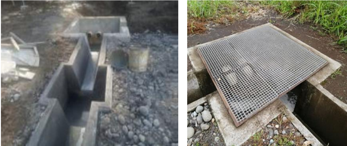
Figura 9 Trampas API TIPO
