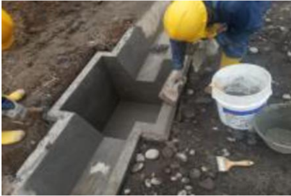
Figura 11 Desarenadores TIPO
