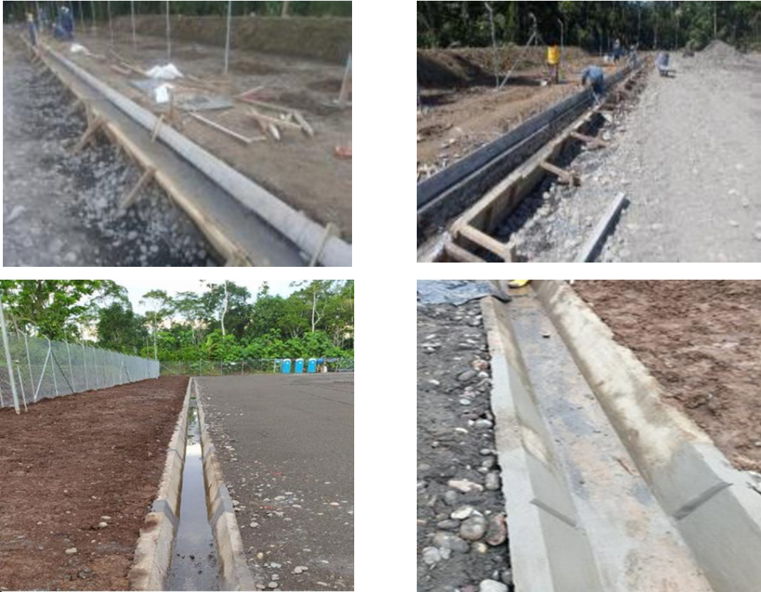
Figura 8 Cunetas Perimetrales TIPO
