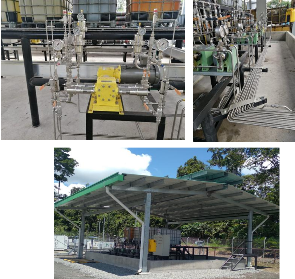
Figura 37 Sistema de Inyección de Químicos TIPO
