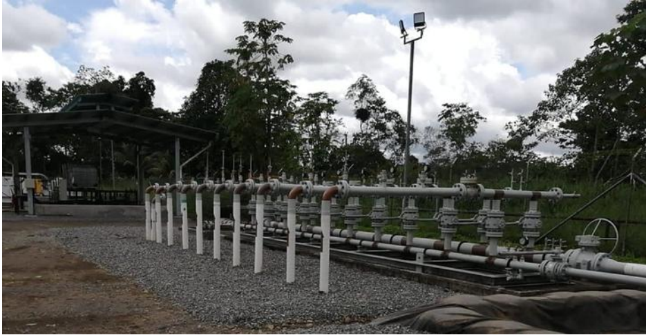
Figura 34 Múltiple de Producción TIPO
