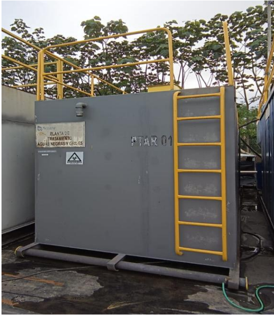
Figura 32 Planta de Tratamiento de Aguas (PTAR) TIPO
