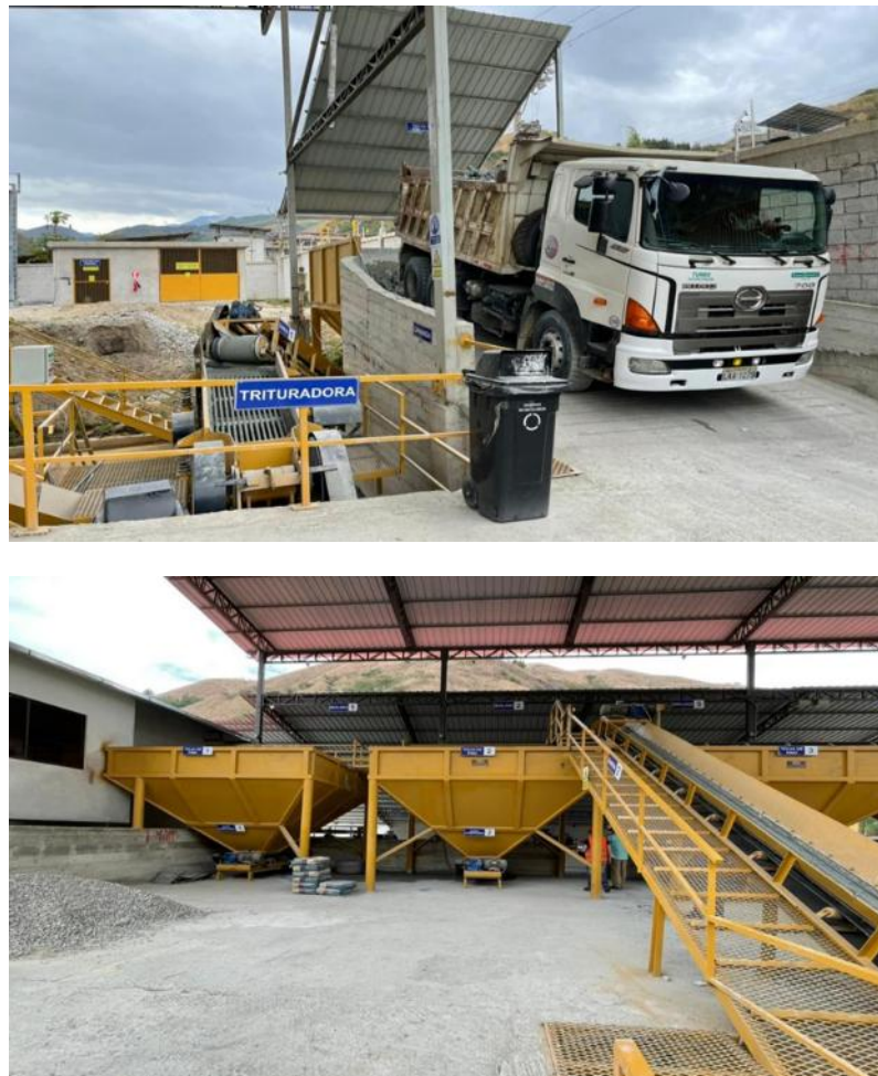
Figura 5-27 Área de recepción de material
