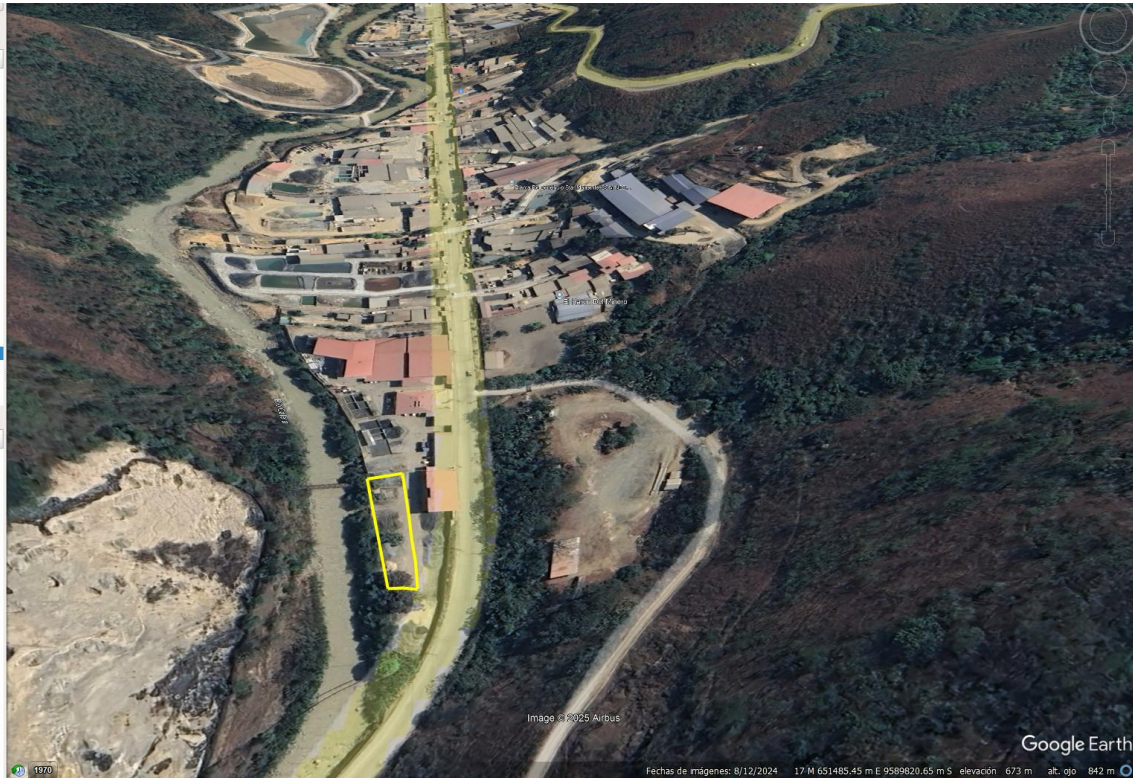
Figura 5 Imagen satelital del área de stock de material Elaborado por: ENERMILL CIA. LTDA./TAIAO CONSULTORES, 2026
