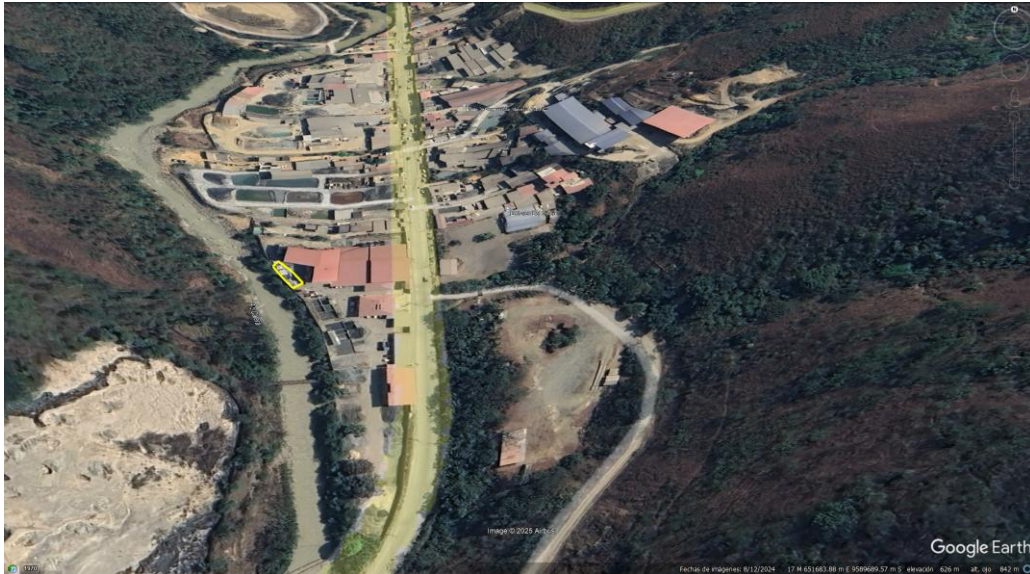
Figura 27 Imagen satelital del área de almacenamiento de concentrados Elaborado por: ENERMILL CIA. LTDA./TAIAO CONSULTORES, 2026
