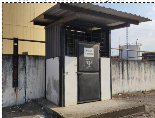
Foto 1.48: Caseta de Emergencia No. 2
