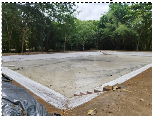
Foto 1.53: Piscina de emergencias
