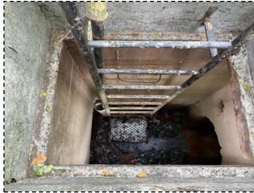
Foto 1.54: Canal de descargas
