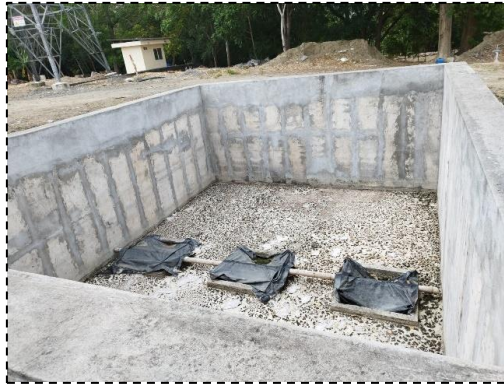
Foto 1.58: Separador API del canal abierto
