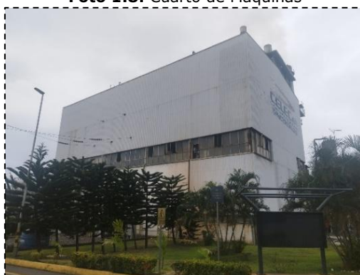
Foto 1.8: Cuarto de Maquinas
