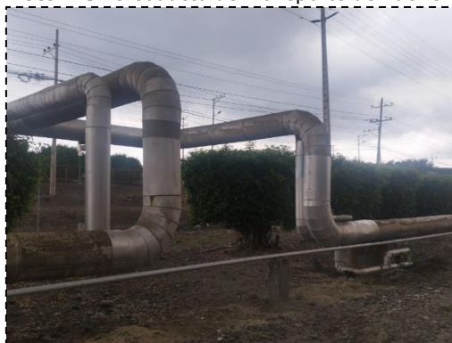
Foto 1.5: Oleoducto de Transporte de Fuel Oil
