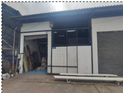
Foto 1.56: Bodega de mantenimiento civil
