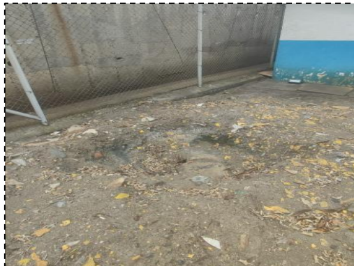
Foto 1.62: Pozo séptico bloque administrativo
