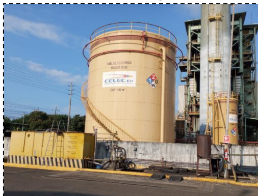
Foto 1.28: Zona de descarga de combustible
