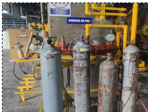
Foto 1.12: Cabezal de CO_2
