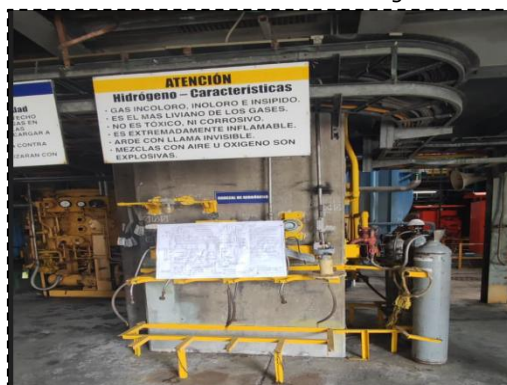
Foto 1.11: Cabezal de Hidrógeno
