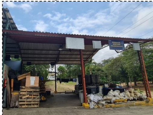
Foto 1.50: Bodega de desechos peligrosos No. 2
