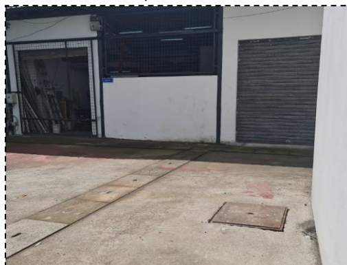
Foto 1.59: Pozo séptico edificio mantenimiento
