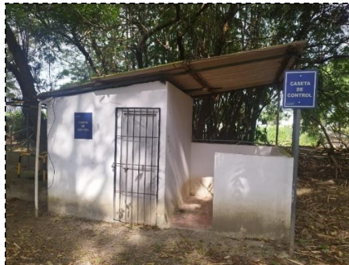
Foto 1.55: Caseta de control
