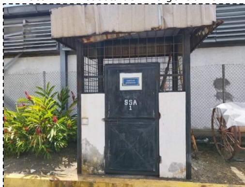
Foto 1.47: Caseta de Emergencia No. 1
