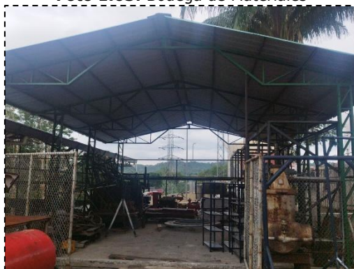
Foto 1.63: Bodega de Materiales
