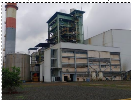
Foto 1.32: Edificio operativo del área de caldera y laboratorio químico
