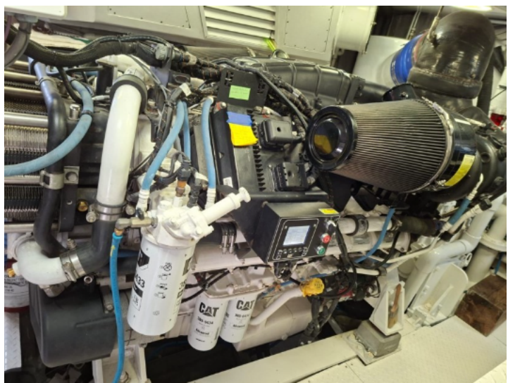
Figura N° 30. Sistema de propulsión principal
